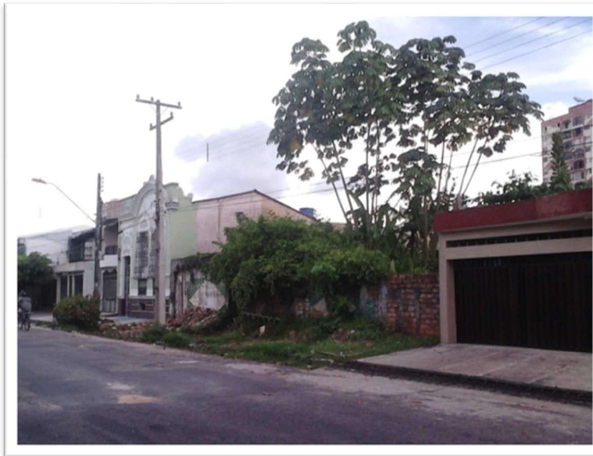
Foto de Escombros de antiga casa situada à Trav. José Pio com Rua do Uma em Belém. Fábio R. Jorge
