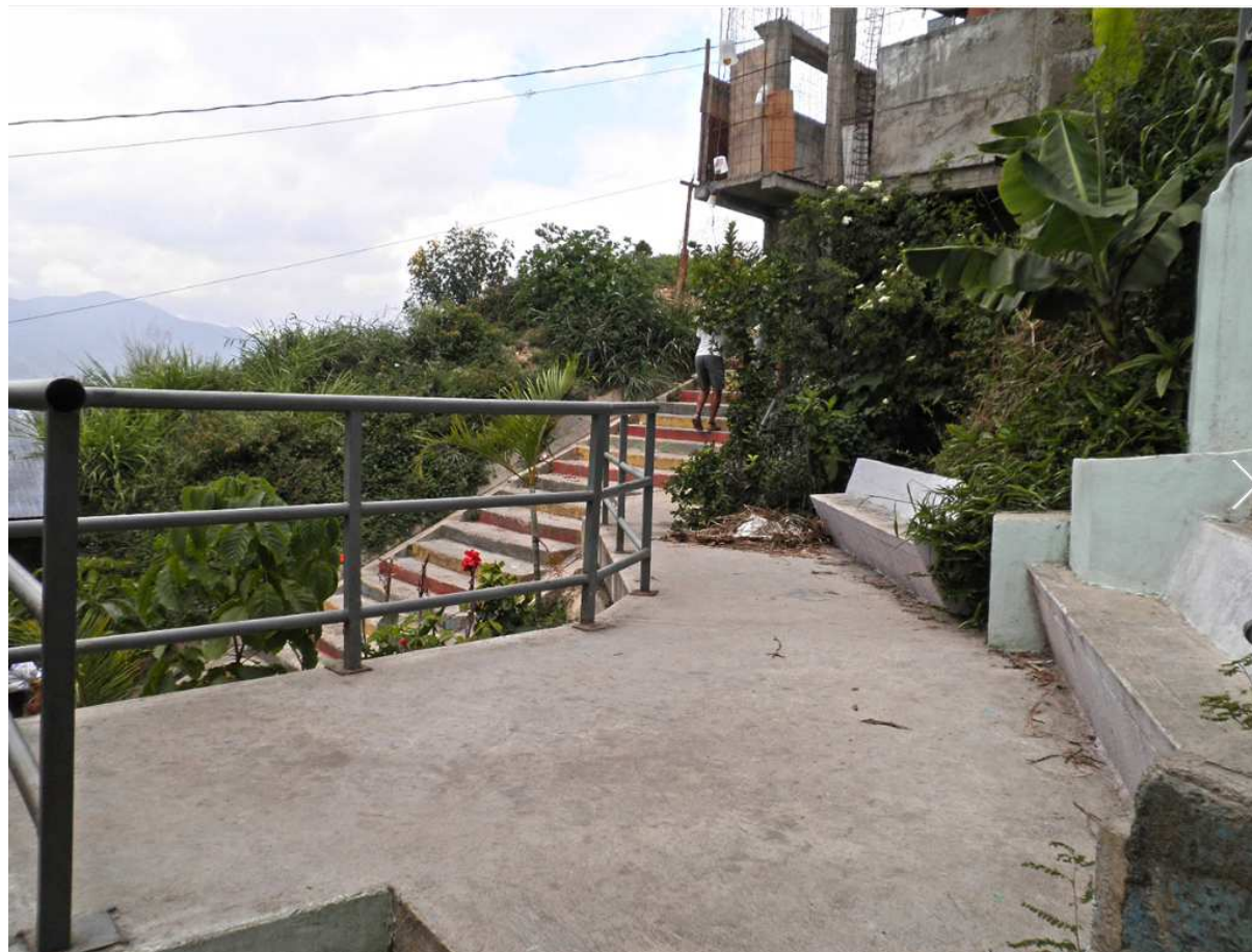
Executado, Morro La Cañonera, Venezuela. Fonte: Enlace Arquitectura
